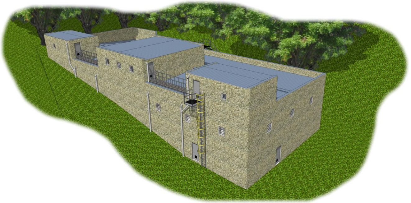
C.3 MITIGAZIONE SERBATOIO CON RIVESTIMENTO IN GEOPIETRA
