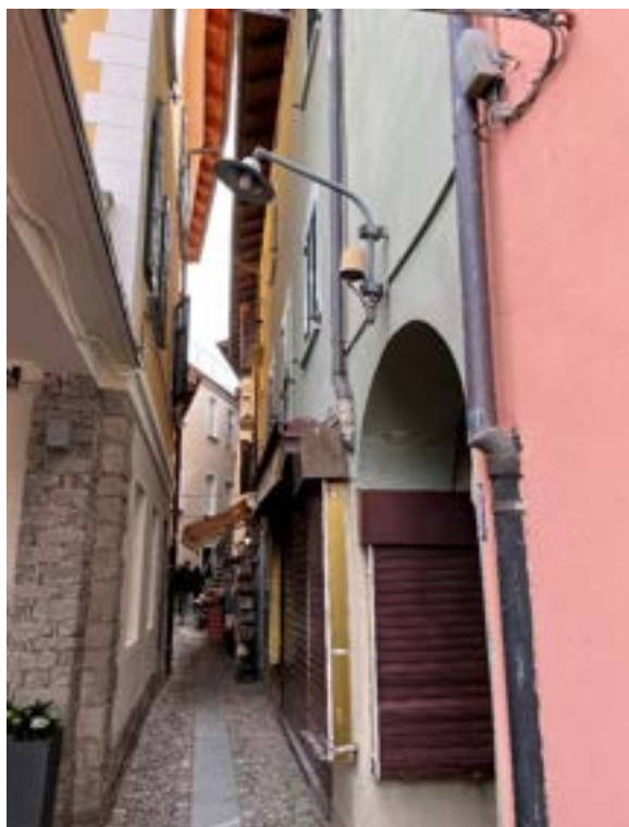
Via di Mezzo – stato di fatto
