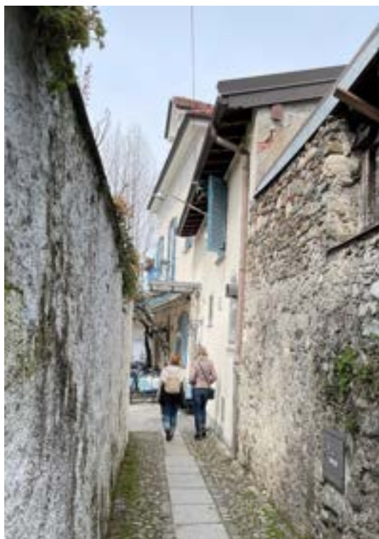
Via di Mezzo – stato di fatto
